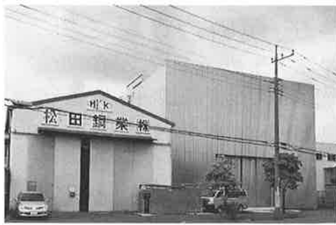
狭山工場外観
