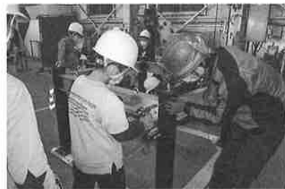
鉄骨建方作業を疑似体験
